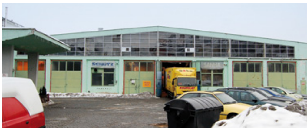
Čelní pohled na garážovou halu
